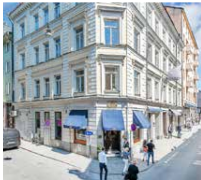
Fastighets AB Norrtulls fastighet på Humlegårdsgatan i Stockholm.
